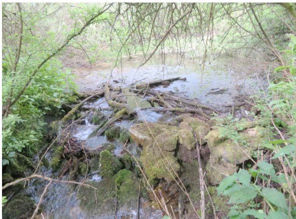
Abb. 9: Aus Wasserbausteinen aufgebauter Sohl- absturz des Stauteiches im Quellbach.
